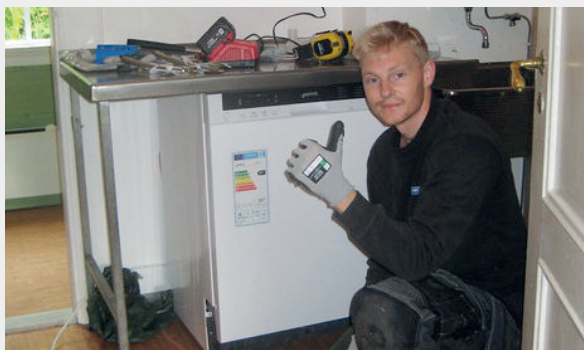
Ny oppvaskmaskin ble montert av Sindre Grønningen, Husnes Røyr.
