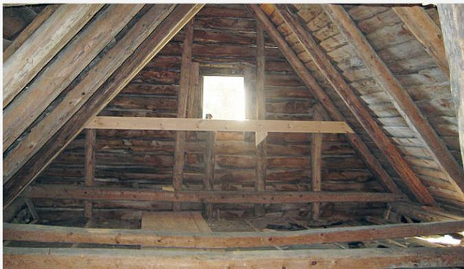
Midlertidig anslag for limtrebjelker, som ble heist inn gjennom gavlvinduet (se også forsiden og s.26)
