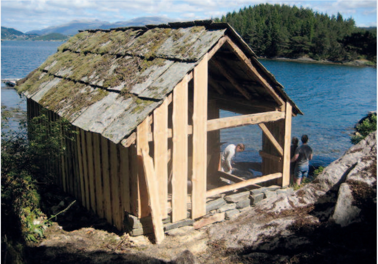
Grindverk jekket opp, ny grunnmur og kledning 19. juni
