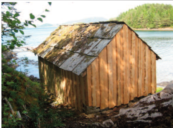
Ferdig restaurert 23.juni
