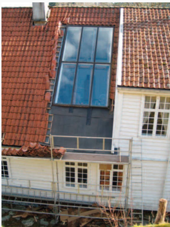
Detaljbilder: Takløsning mellom ateliervindu og pultarken.
