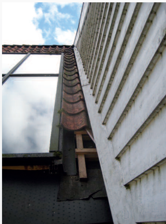
Detaljbilder: Takløsning mellom ateliervindu og pultarken.
