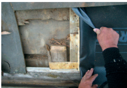
Detaljer fra restaureringen.
