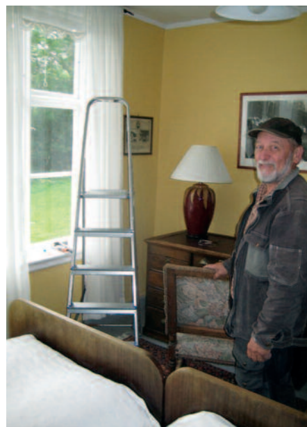
Vindusrestaurering Hovedhus. Ingemund Gjærde.
