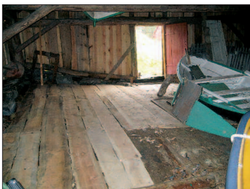
Gulvet i Hovednøstet ble restaurert 2007.
